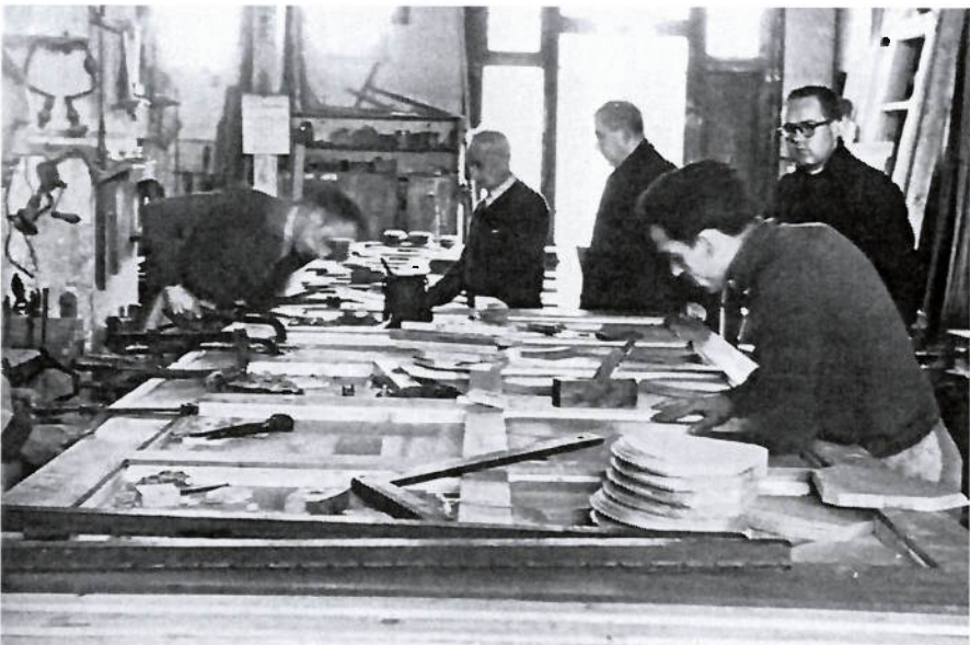
1953 Fusteria Godas, treball de construcció de la porta de l'església. (fotografia B. Pey)
