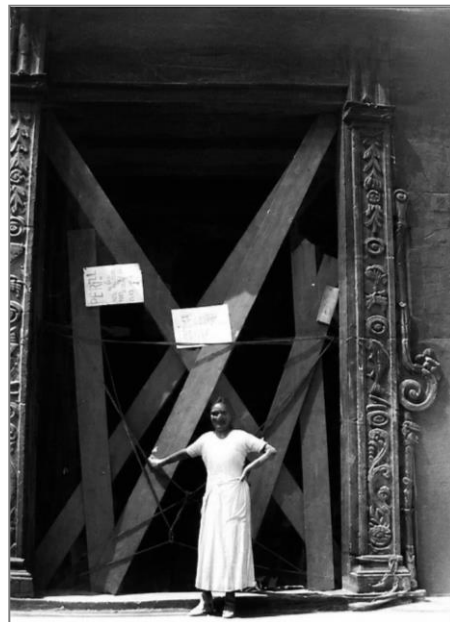
El portal de l'església després de l'incendi (juliol 1936)
