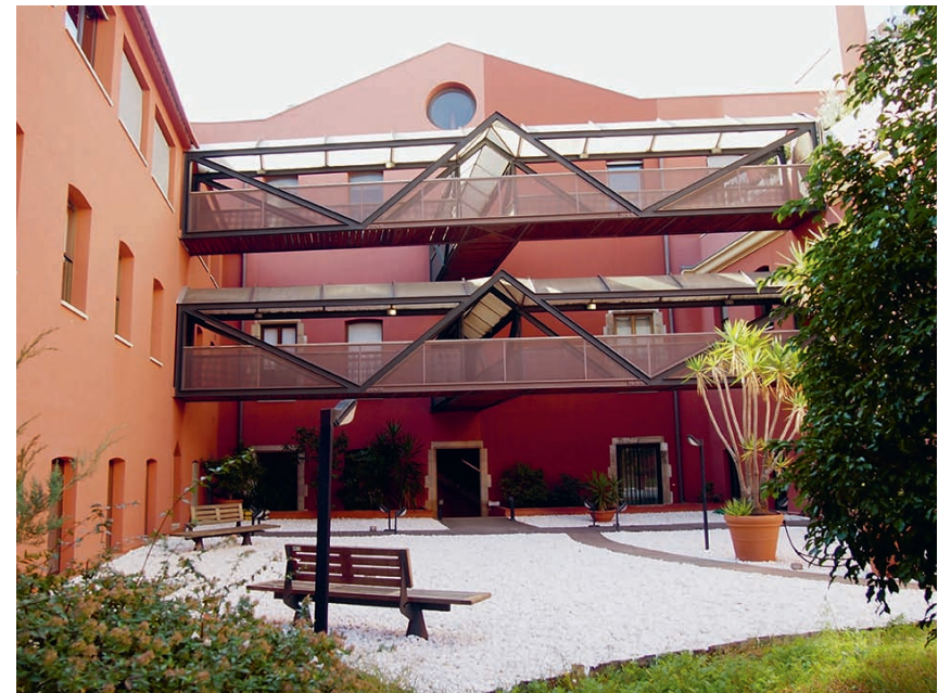
Pati de la parcel·la del carrer de Jonqueres, 10, després de la rehabilitació de 1997
