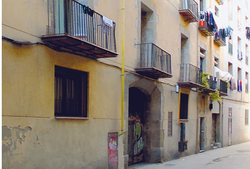
Carrer d'en Cortines, 25- 27. Detall de la gran portalada d'entrada, símptoma inequívoc d'una important activitat comercial o industrial
