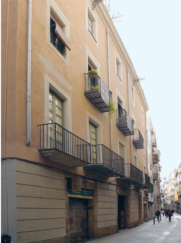
Façana de la casa-fàbrica Casas, recentment rehabilitada amb la transformació de la finestra original en una nova porta d'escala de veïns
